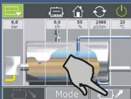
Figure 3 : Commande du BCO (Boiler Control) – le démarrage automatique de la chaudière est assuré par une pression sur l'icône de l'écran tactile « Démarrer » ou un signal externe.
